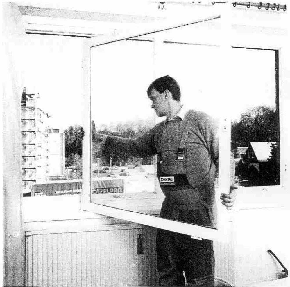
Ohne größeren Aufwand geht die Sanierung vonstatten: Die alten Flügel werden abgenommen... Foto: REHAU
